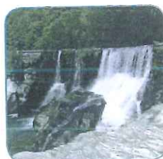
seuil sur le Gardon de Mialet
